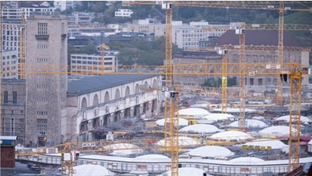
So sieht die Baustelle in Stuttgart aktuell (2022) von oben aus.
