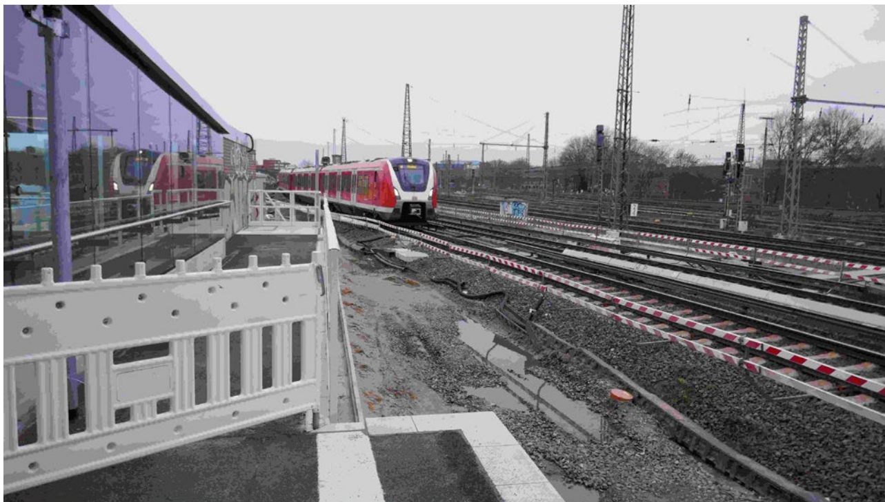
S-Bahnhof Diebsteich Januar 2025
