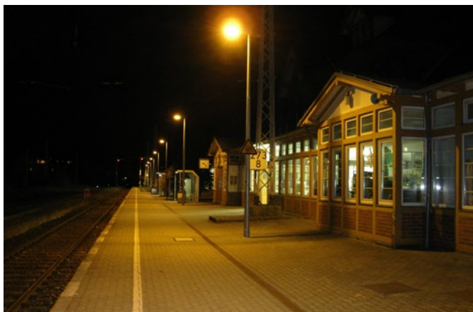
Kleinstadtbahnhöfe in Niedersachsen
