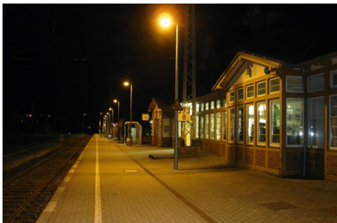
Kleinstadtbahnhöfe in Niedersachsen
