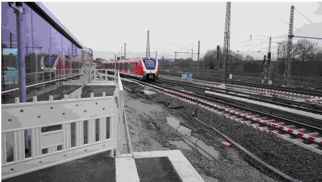
S-Bahnhof Diebsteich Januar 2025
